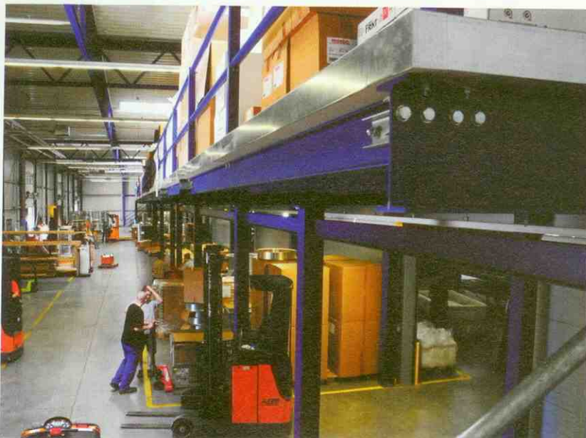
Bei LTI wurden durch Stahlbühnen zusätzliche 307 m 2 im Wareneingang geschaffen. Das Verpackungsmaterial lagert in einer Höhe von 3,60 m
